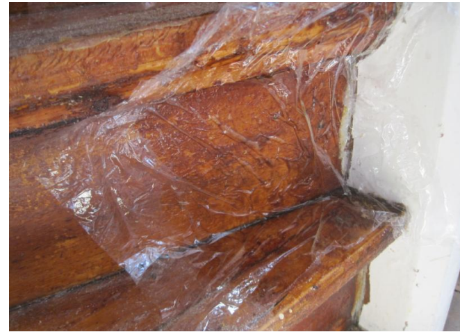
Pensla på Paint & Glue Remover, täck med plastfolie, låt verka 1 timme eller mer
